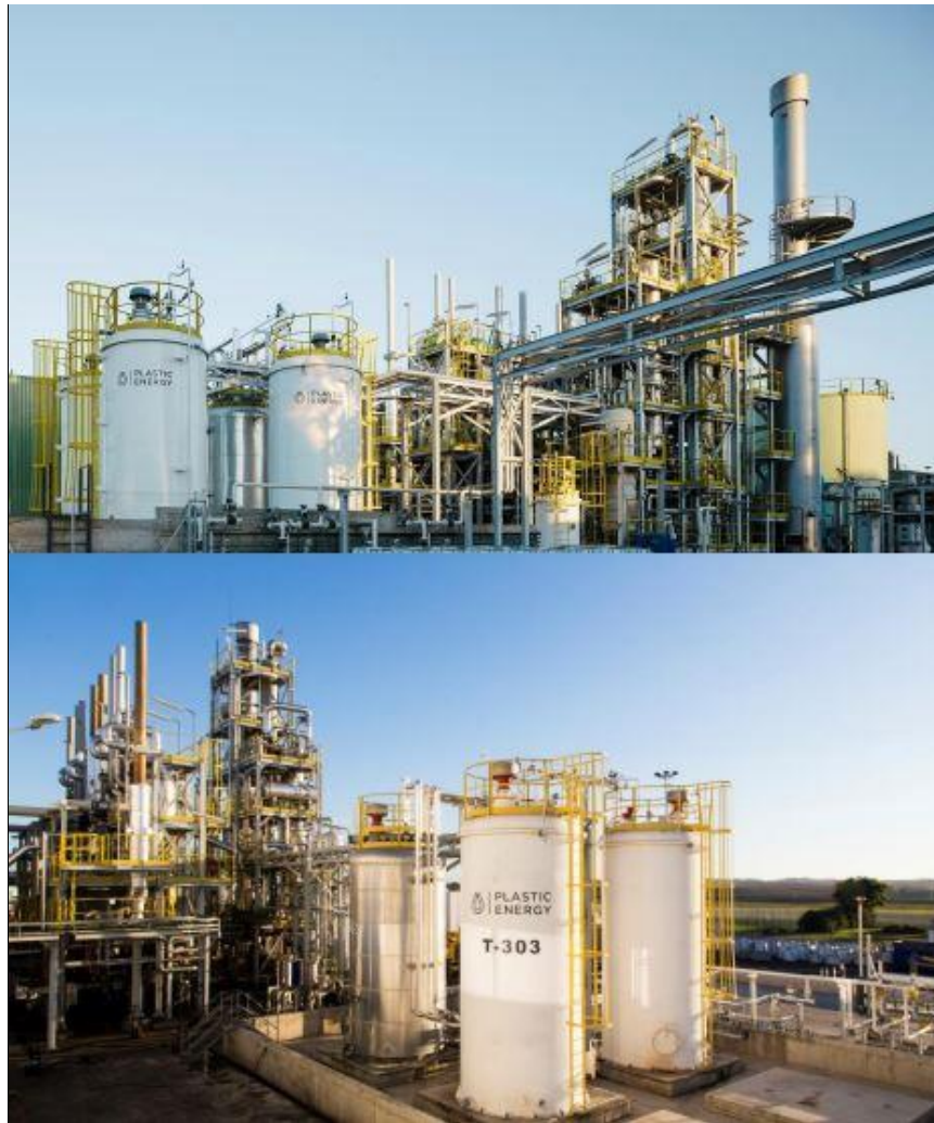
Obrázek 9: Technologie pyrolýzy odpadních plastů společnosti Plastic energy, Španělsko [12]
