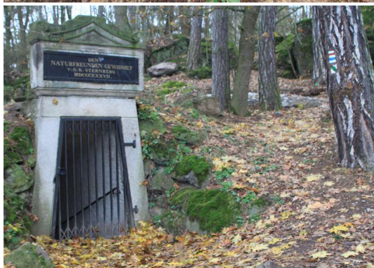
7. Část nově vyzmáhané staré štoly, červen 2017.
